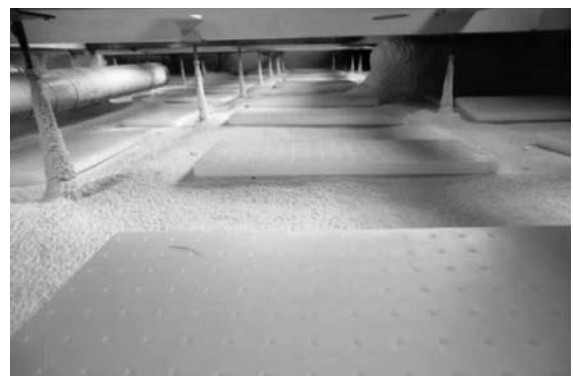
写真2 床下に敷設されたシリカゲル・PCMプレート
